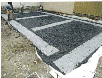
③ 免震の地盤改良が完了した様子です。
