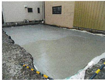
④ 全体にコンクリートを敷いて、基礎工事の準備が整いました！
