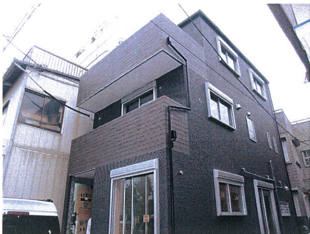
木造3階建ての二世帯注文住宅です。
