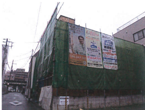
木造2階建ての耐震リフォーム住宅「まるで新築さん」です。
